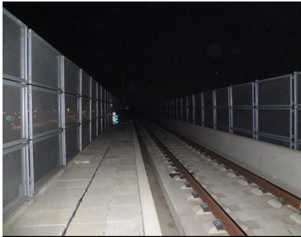
교량 상부 전경
