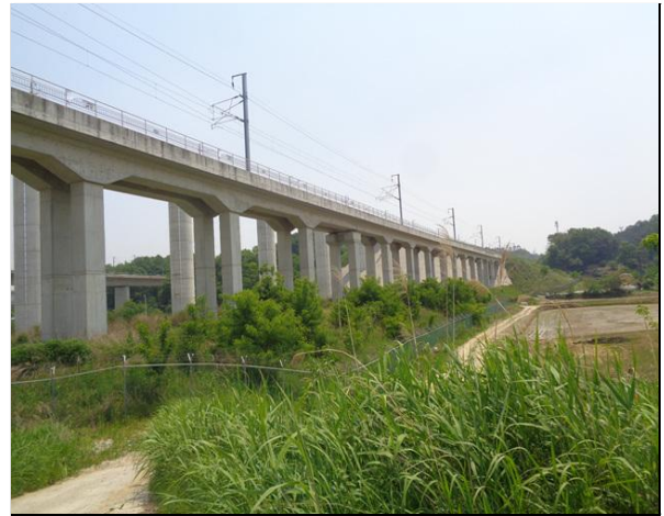
교량 측면 전경
